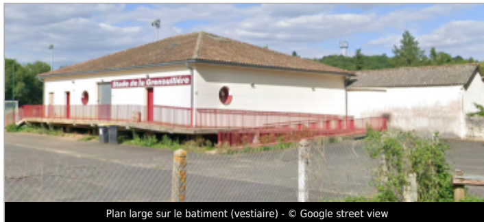
Plan large sur le bâtiment (vestiaire) - © Google street view
