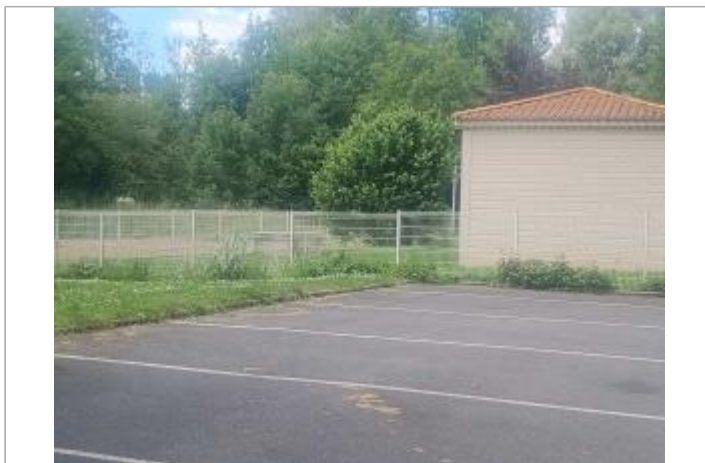
Vue sur le parking
