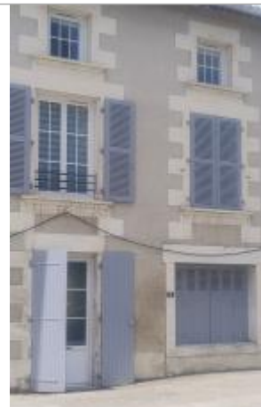
Vue sur la façade d'habitation
