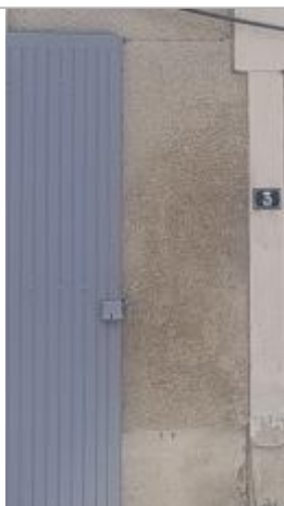
Vue sur la façade
