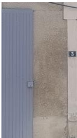
Vue sur la façade
