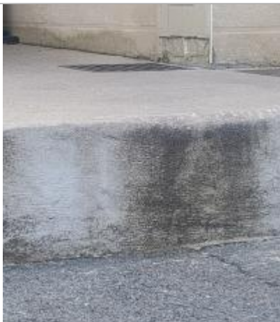
Dalle en béton - témoignage - montée de l'eau au seuil de la cuisine
