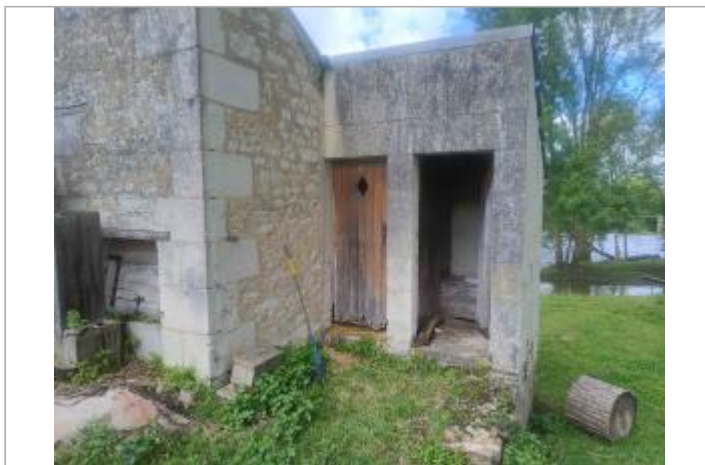
Moulin - Cabinet de toilettes
