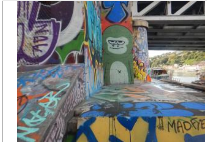
Base du pont SNCF. Coté amont. Rive gauche de la Saône.
