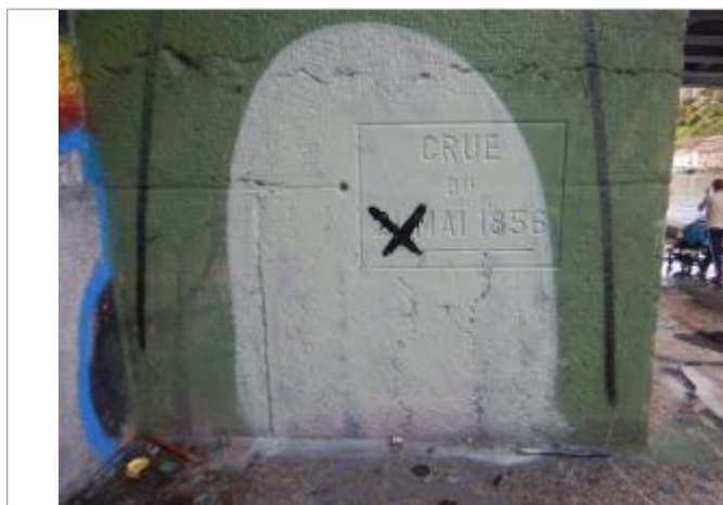
Repère de crue. Photo prise le 22/09/2025 (S. Gaillot; Ville de Lyon, Direction de l'archéologie)
