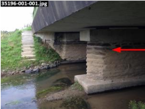
laisse d'inondation sur les piles de pont (boues séchées) (photo DHE)
