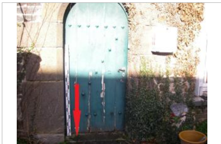
Seuil d'entrée de la maison (photo DHE)
