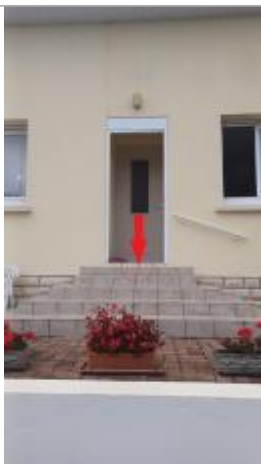
Laisse de crue à 11 cm/sol de la marche.
