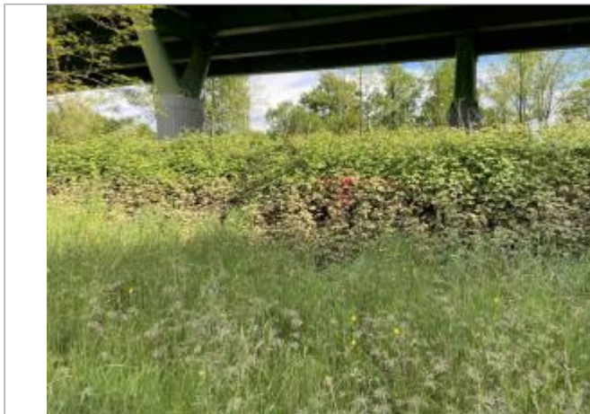
Vue du site - auteur : AGERIN
