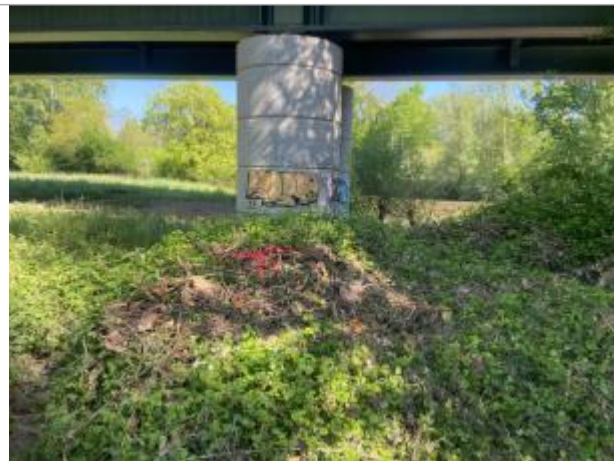
Vue du site - auteur : AGERIN
