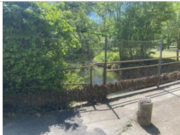
Vue du site - auteur : AGERIN
