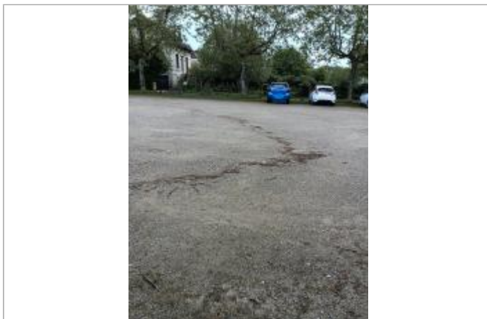
Vue du site - auteur : AGERIN
