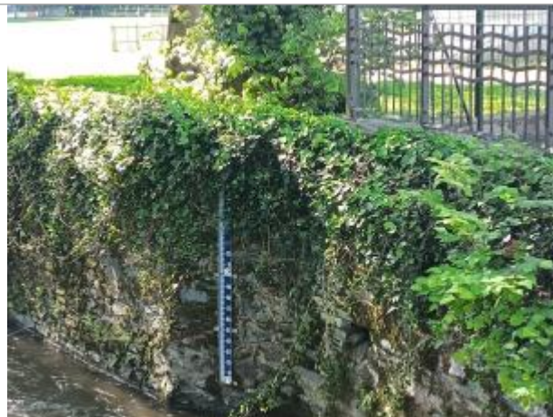
Vue du site - auteur : AGERIN
