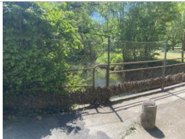
Vue du site - auteur : AGERIN
