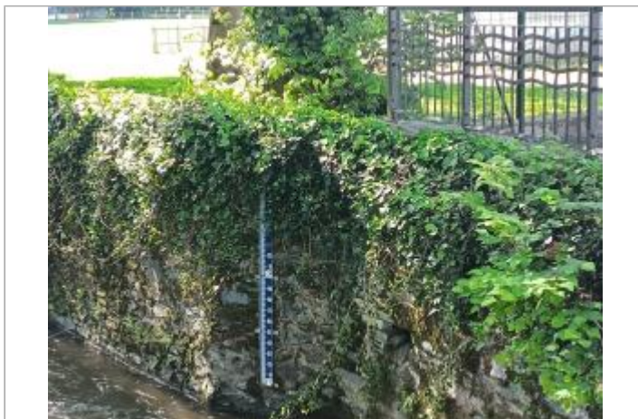
Vue du site - auteur : AGERIN
