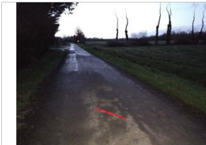
chaussée de la route de Bontemps à Goven
