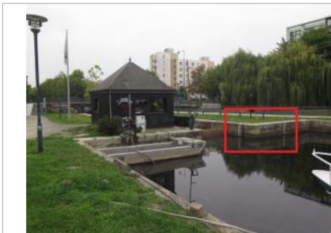
Echelles amont de l'écluse de Saint Martin à Rennes
