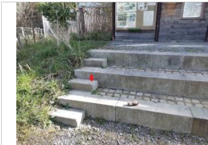
Marches de la maison (photo Rennes Métropole)
