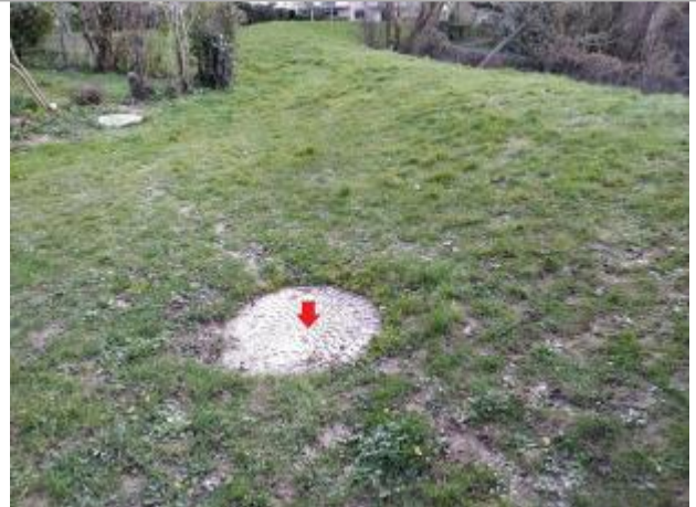
Dessus de la plaque réseau d'assainissement (photo Rennes Métropole)
