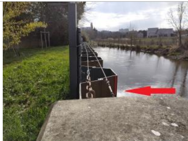
rideau de palplanches au bout de la rue des folies (photo Rennes Métropole)
