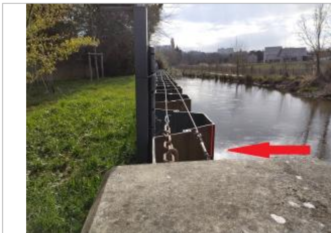
rideau de palplanches au bout de la rue des folies (photo Rennes Métropole)
