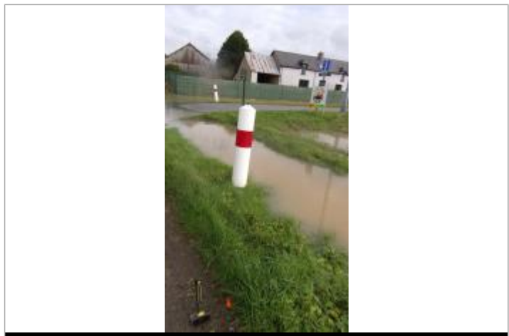
carrefour au lieu-dit "Terron" le 30/01/2025 - photo CEREMA Ouest
