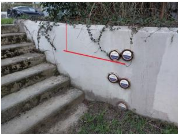
Relevé du niveau de l'inondation à coté des repères existants (photo Rennes Métropole)
