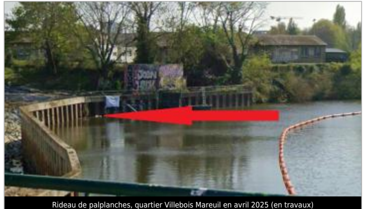
Rideau de palplanches, quartier Villebois Mareuil en avril 2025 (en travaux)
