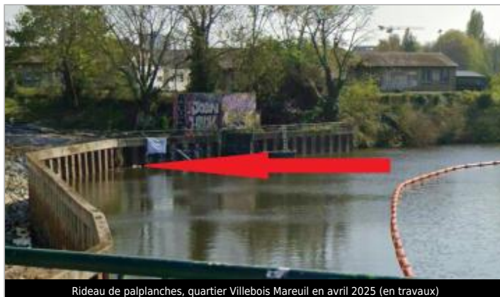
Rideau de palplanches, quartier Villebois Mareuil en avril 2025 (en travaux)
