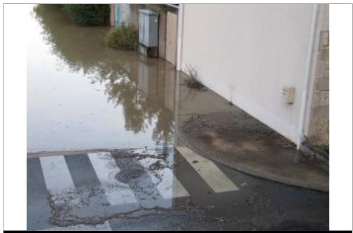
Vue sur le passage piéton (entrée parking) © Patrice Petit
