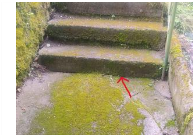
Indication du niveau d'eau atteint (2024) selon le témoignage
