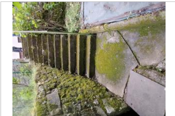
Vue sur l'escalier (12 rue de Clotet)
