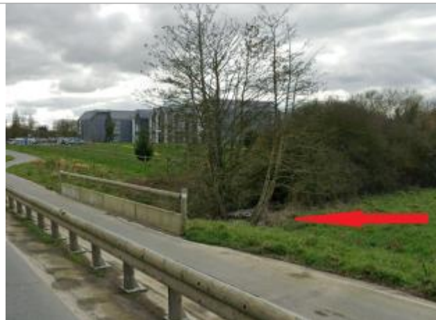
Aval du pont de la RD 82 sur l'Orson
