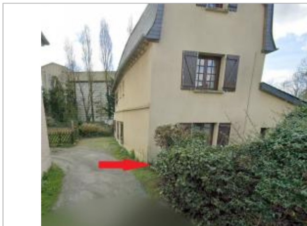
rue au niveau du n°6 allée de la Seiche
