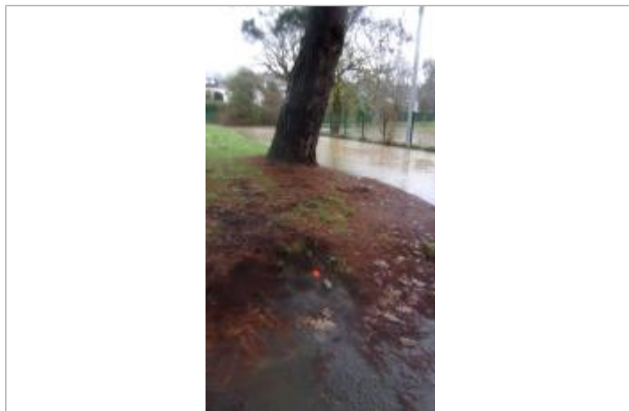
Relevé laisse d'inondation sur le complexe sportif
