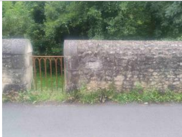
Vue sur le muret rue des 4 roues
