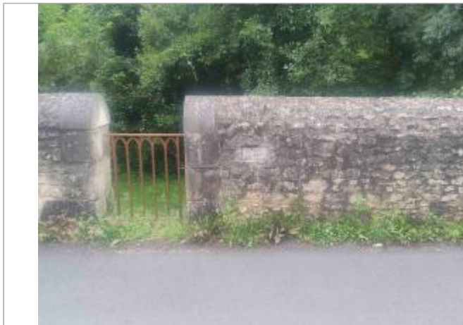
Vue sur le muret rue des 4 roues
