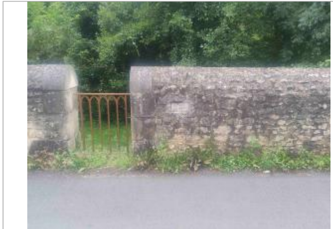
Vue sur le muret rue des 4 roues
