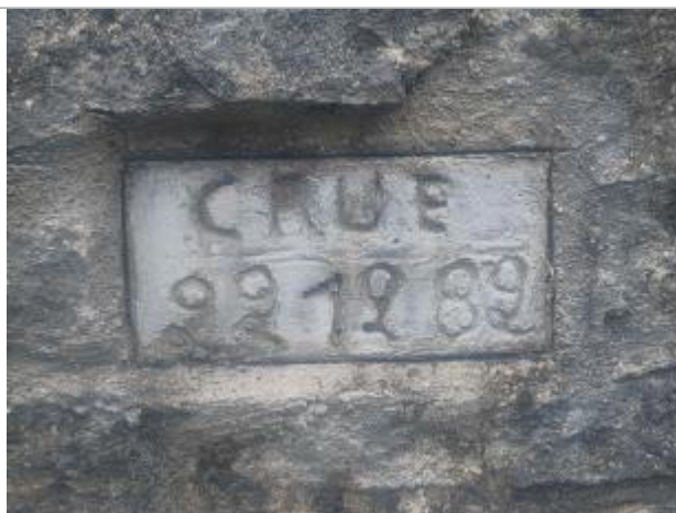
Vue sur la marque de crue gravée
