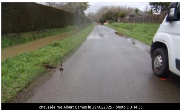
chaussée rue Albert Camus le 29/01/2025 - photo DDTM 35
