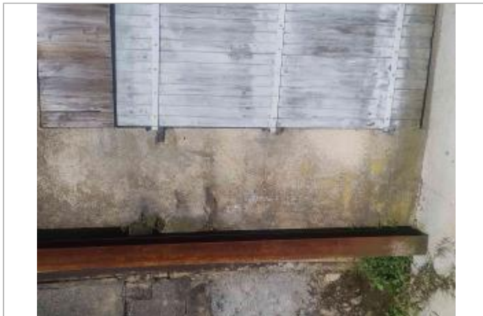
Vue sur le support (entre le pilier de soutien et le volet)
