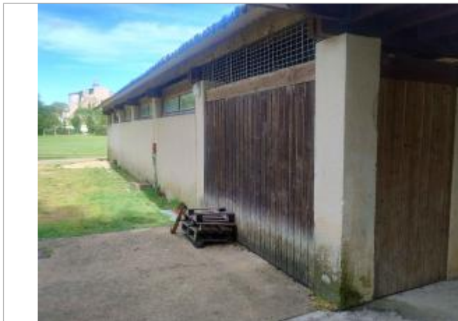
Vue sur le bâtiment (au sud des terrains)
