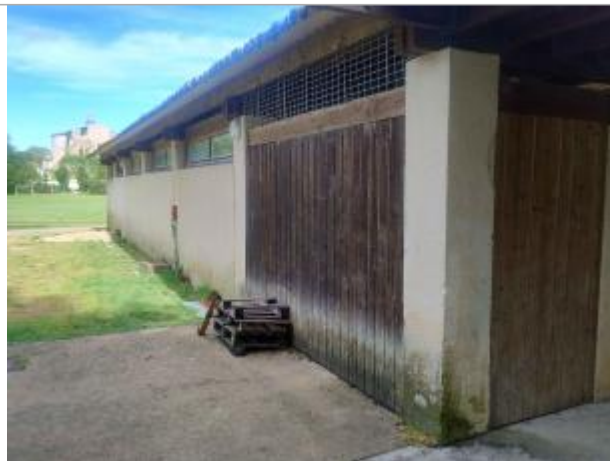
Vue sur le bâtiment (au sud des terrains)
