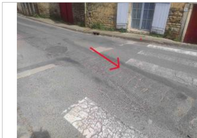
Indication du niveau de l'eau en 1982 (témoignage)
