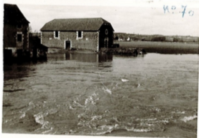
Vue sur la Ferme du Pont en 1982 © Patrick Liege
