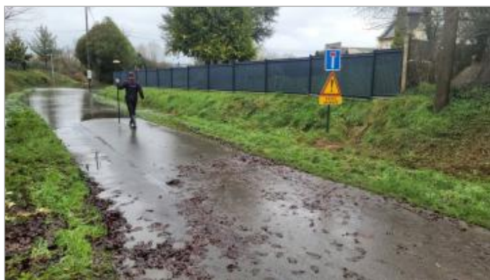
route au lieu-dit La Tremblais - le Coudray le 29/01/2025 - photo CEREMA Ouest
