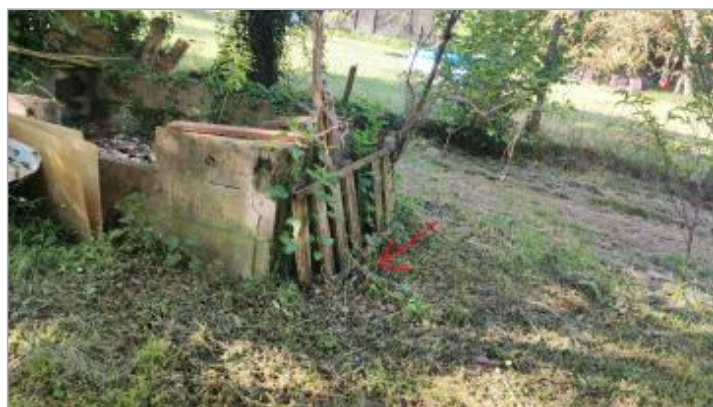
Vue sur le muret (parpaing)
