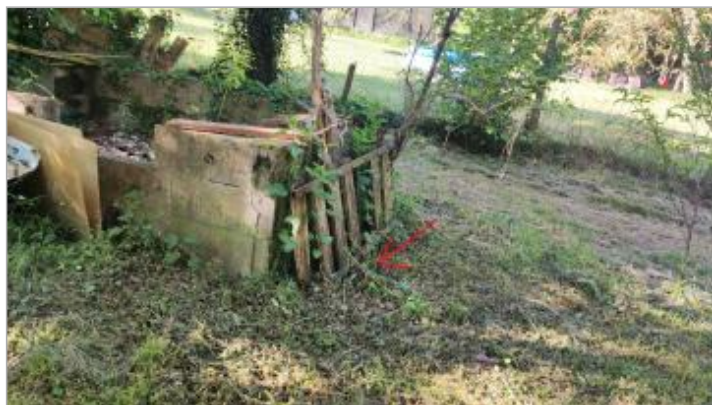
Vue sur le muret (parpaing)
