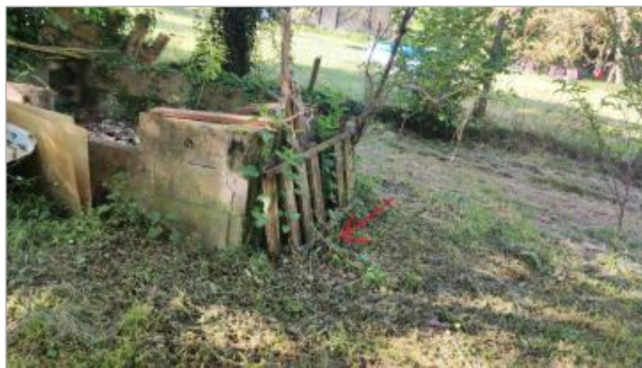
Vue sur le muret (parpaing)
