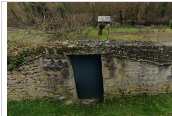
- Mur en pierre - Rue Monfleury
