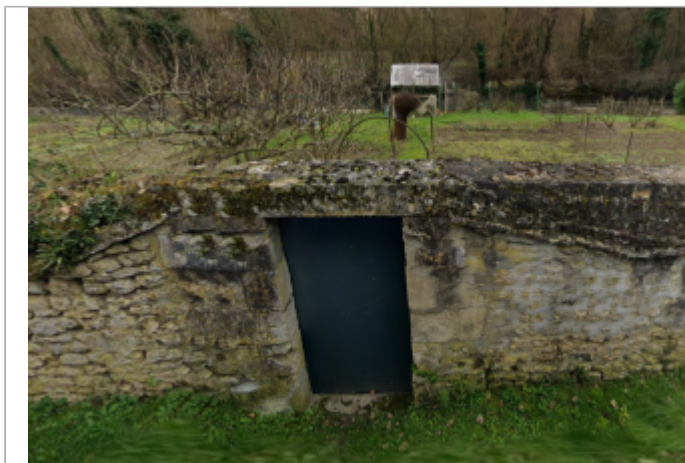
- Mur en pierre - Rue Monfleury
