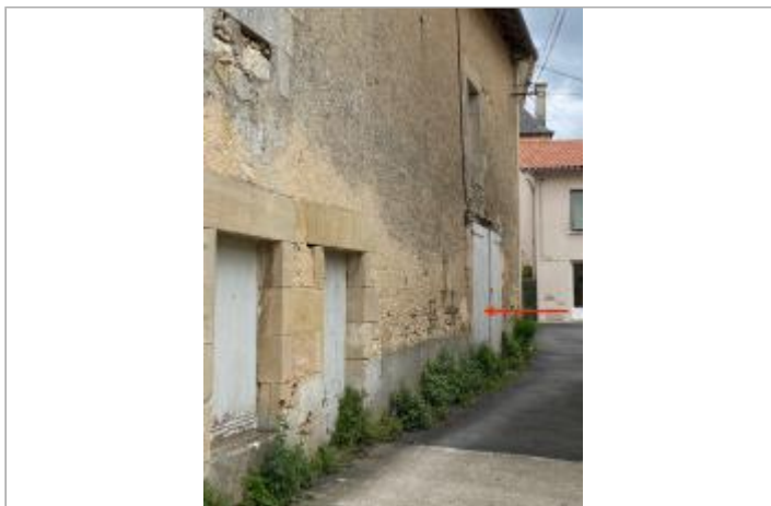
Vue sur le garage de l'habitation
