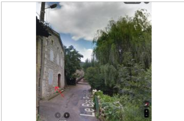
Façade de maison en aval du pont de la RD120
