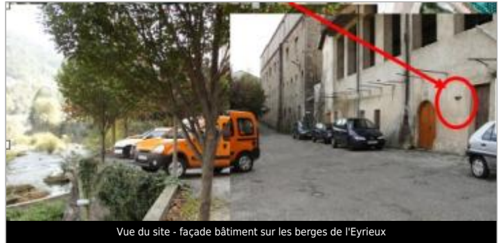
Vue du site - façade bâtiment sur les berges de l'Eyrieux
