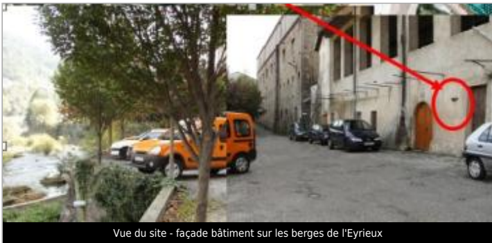
Vue du site - façade bâtiment sur les berges de l'Eyrieux
