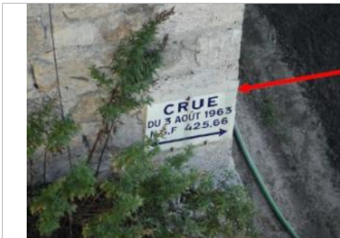
vue du repère sur le mur de la maison sous le pont
