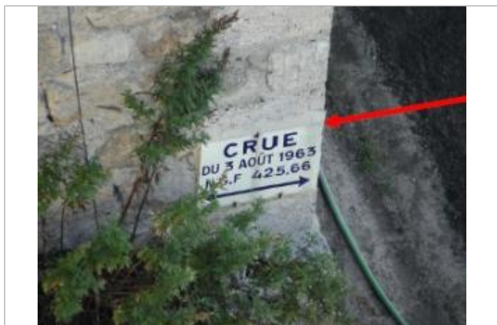
vue du repère sur le mur de la maison sous le pont
