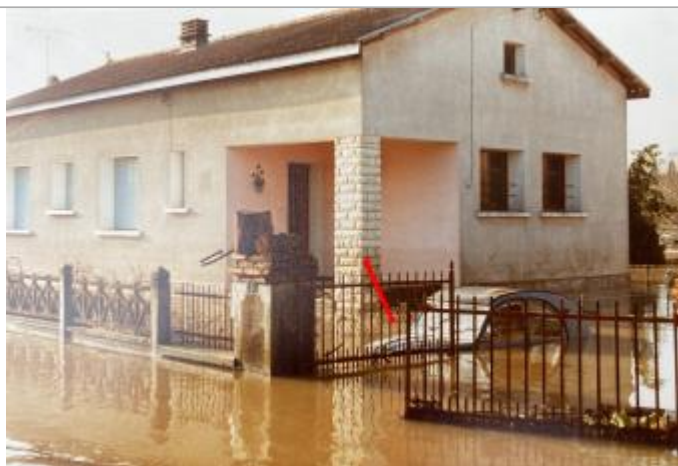
Vue sur le pilier et la trace de la hauteur d'eau (© Puigrenier)
